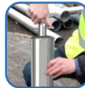
3. 延長用ポールを穴に差し込み、所定の位置にねじ込む
