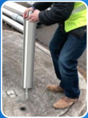
準備作業でベースソケットに合うように地面に穴を開ける必要がありますが、これは1回限りの作業です。延長用ポールの設置には必ずベースソケットが取り付けられていなければなりません。これにより、延長用ポールが地面に対して適切な角度で固定されます。ベースソケットが固定されれば、延長用ポールはベースソケットより取り外せる状態となり、必要な時にいつでも延長ポールを取り付けることができます。
